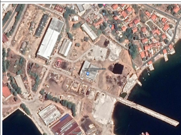
Captura de pantalla de vista de Google Maps de hoy, 22 de octubre de 2020. Arriba a la derecha ya no quedan sacas de arena contaminada, han sido ya demolidos varios edificios y realizados drenajes de líquidos contaminados. Aparece ubicada la empresa Valgo en este escenario.
