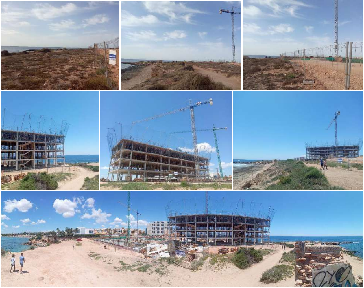
Evolución de la nueva urbanización en Cala Mosca. Las tres imágenes superiores corresponden a los inicios de las obras, en el año 2020. Las imágenes centrales muestran las obras en la actualidad, y la inferior, es una panorámica de la zona, en la que es evidente la densidad de edificios en la zona. Fotos: Pablo Muñoz Nieto.
