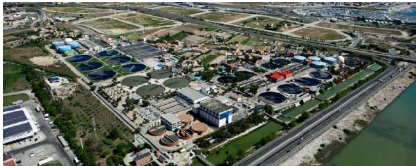
Instalaciones de la depuradora de Pinedo. Foto: Depuración de Aguas del Mediterráneo
