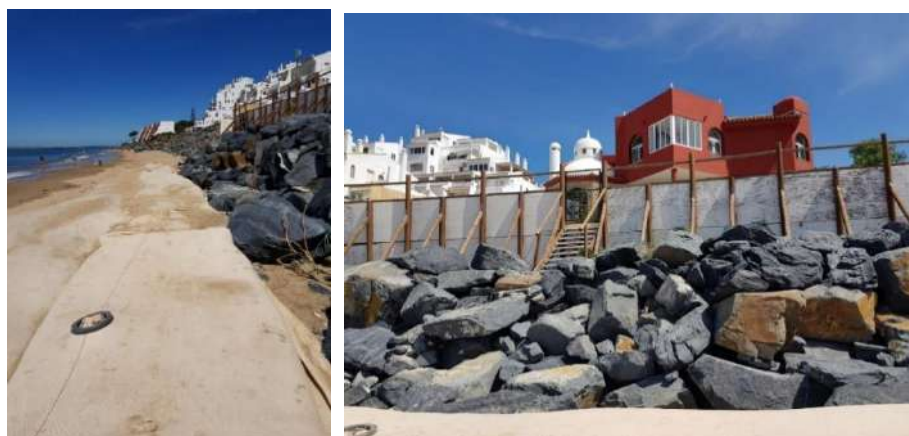
Izquierda - Línea de construcciones y piedras de protección sobre la playa de El Portil. Derecha - Muros y piedras para proteger las urbanizaciones de El Portil. Fotos: Ecologistas en Acción de Huelva
