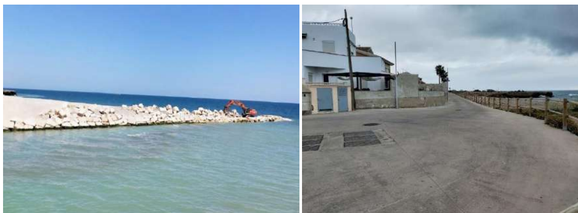
Izquierda - Junio de 2020. Creación del espigón de canalización del río Cervol en su desembocadura. Derecha - Mayo de 2021. Aspecto de la zona reparada y regenerada. Fotos: Apnal-Ecologistas en Acción de Vinaròs.
