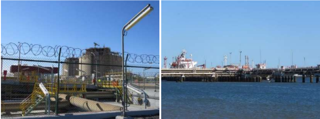
Izquierda - Depósitos de metano. Derecha - Instalaciones del Puerto Exterior. Foto: Ecologistas en Acción de Huelva
