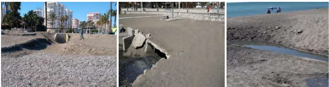
Izquierda - Vertido de pluviales playa Torre del Mar. Foto: Rafael Yus. Centro y derecha - Vertido de pluviales en Playa de Huelin (Málaga). Fotos: Rafael Yus
