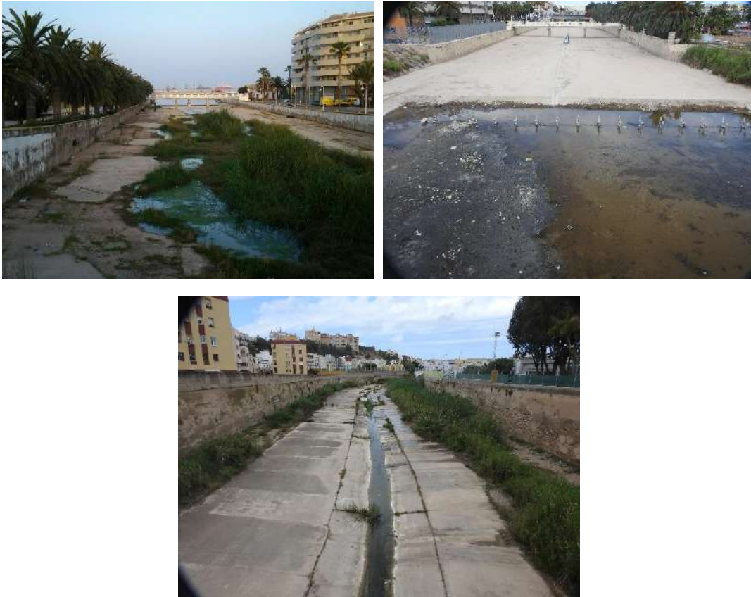
Arriba - Desembocadura del río de Oro antes y después de hormigonar y poner fuente. Se proyecta inundarla. Abajo - Último tramo del río de Oro antes de la desembocadura. Mayo de 2021. Se proyecta inundarlo. Fotos: Guelaya-Ecologistas en Acción
