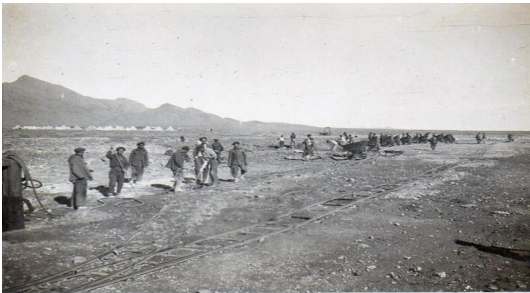
Trabajos de construcción del Transahariano
